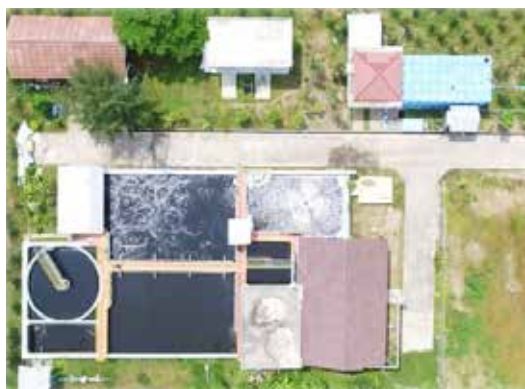
Proyek WWTP Saat Ini Current WWTP Project
