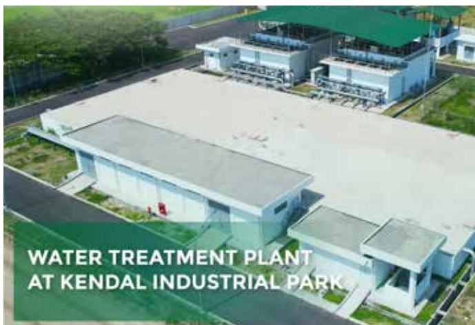
Instalasi Pengolahan Air PT Kawasan Industri Kendal Water Treatment Plant PT Kawasan Industri Kendal
